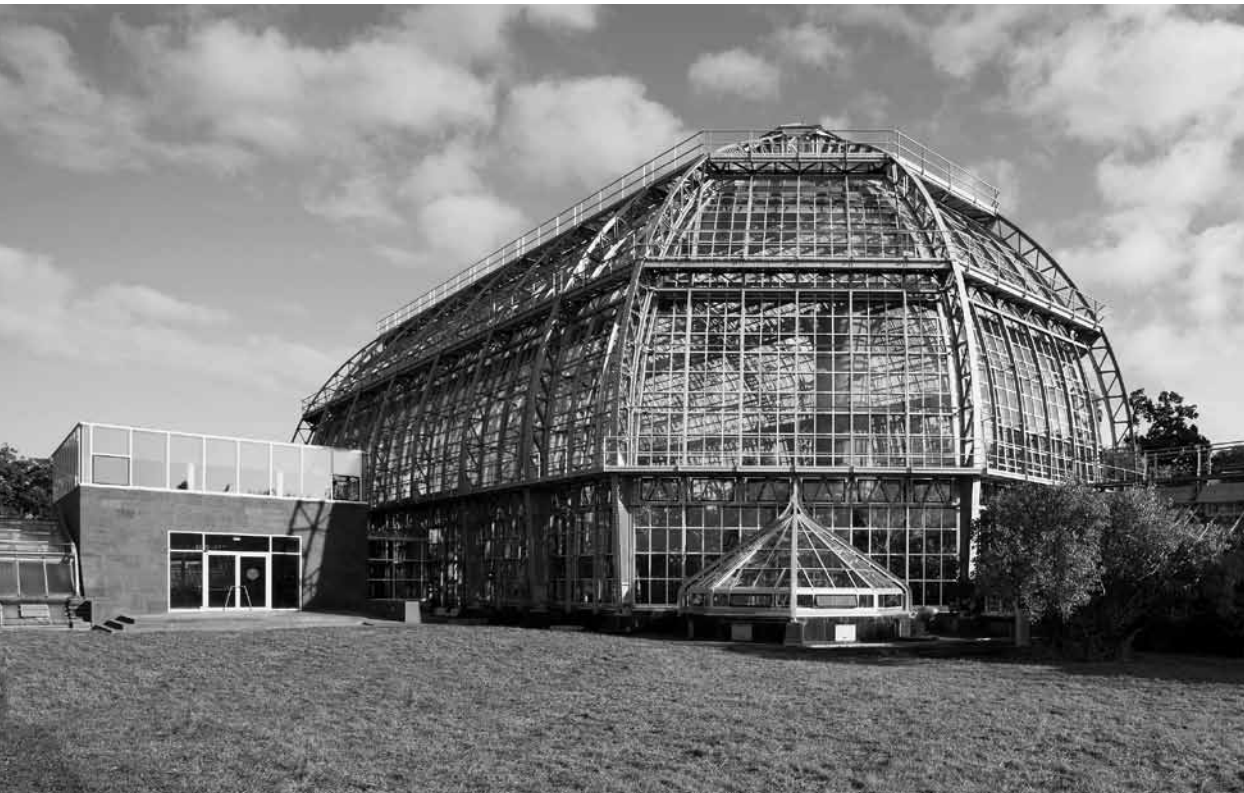
Komplettsanierung Großes Tropenhaus im Botanischen Garten Berlin, 2009
