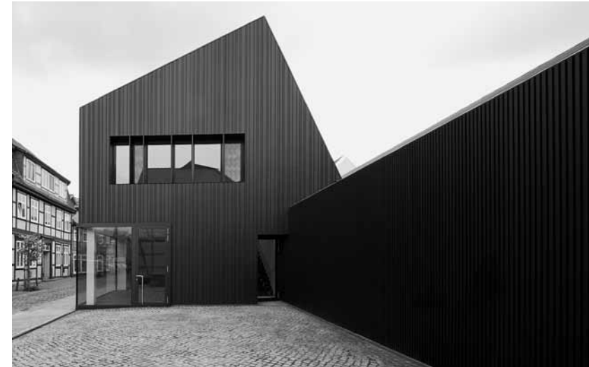
Erweiterung NYA Nordiska Dannenberg
